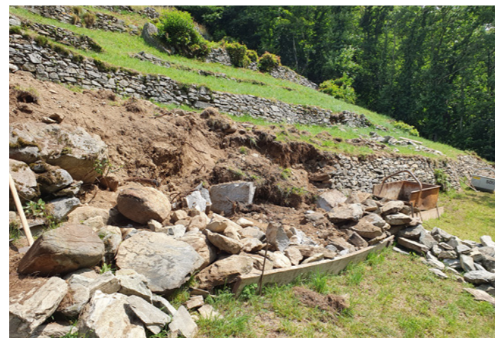
Wiederaufbau der Trockenmauern in der Zone «Coste»
