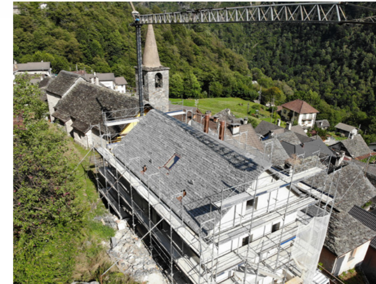
Neugedecktes Steindach des Pfarrhauses von Menzonio
