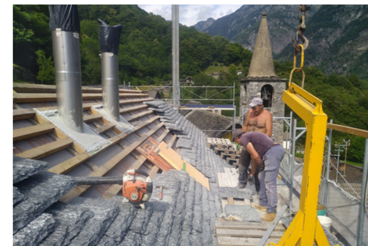
Dachdecker beim Verlegen der Steinplatten auf dem Dach
