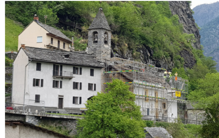
Die Wiederherstellung des Daches der Kirche von Brontallo
