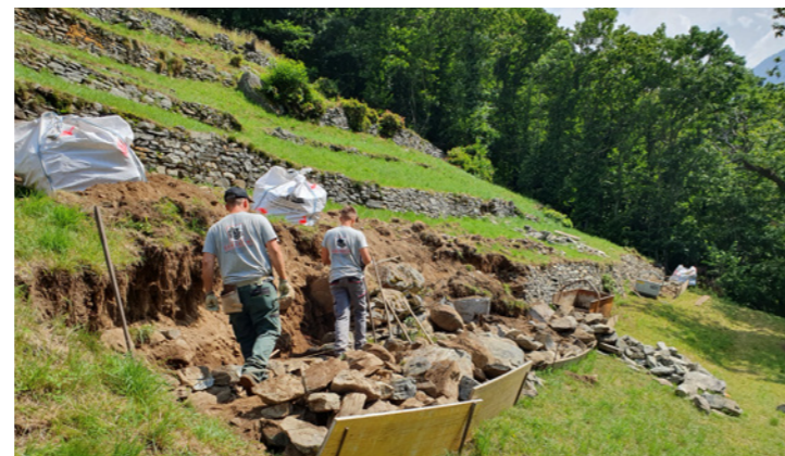
Bereich «Coste» Wiederaufbau der Trockenmauern
