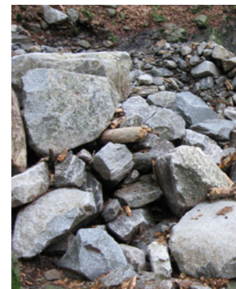
Chute de pierres dans le Val Cocco
