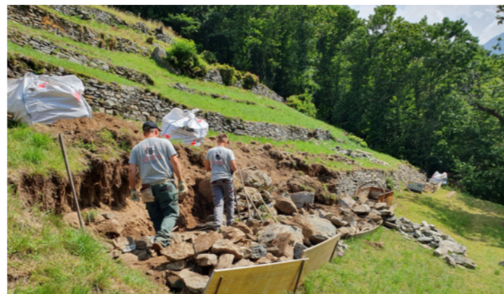
Reconstruction des murs en pierres sèches dans le secteur de «Coste»
