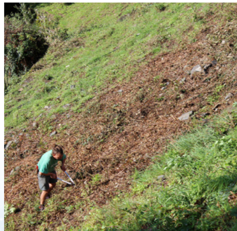
Travaux d'entretien à Brontallo
