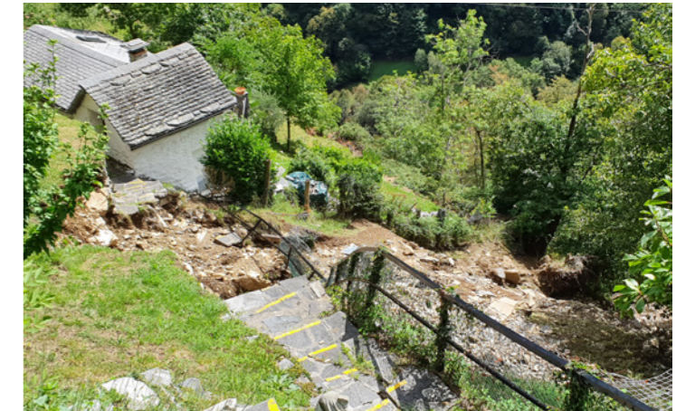
Une grande partie de l'escalier en pierres s'est effondrée en raison des fortes pluies
