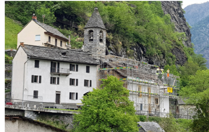
Travaux pendant la reconstruction du toit de l'église de Brontallo
