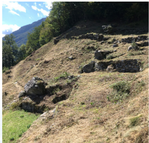
Après les travaux d'entretien à Taneda
