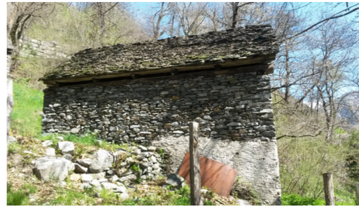
Renovation eines Gebäudes
