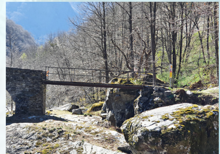
Der Brückenteil, welcher wieder Instand gestellt werden soll
