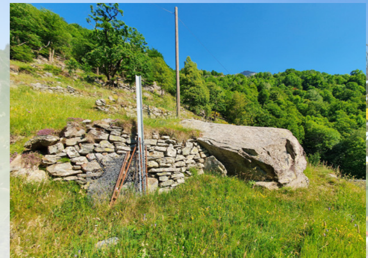
Die vorhandenen Felsblöcke wurden in den Bau der Trockenmauern integriert.
