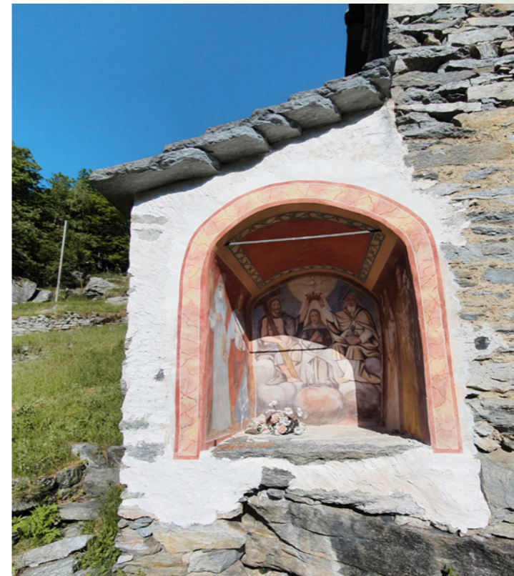
Die «Capéla du Pignáta» wurde 2005 restauriert.
