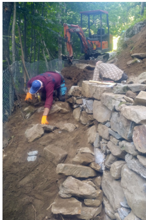
Wiederaufbau von Stützmauern
