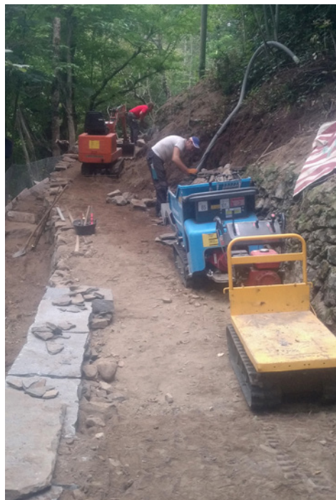
Wiederherstellung von Trockenmauern am Wegrand entlang
