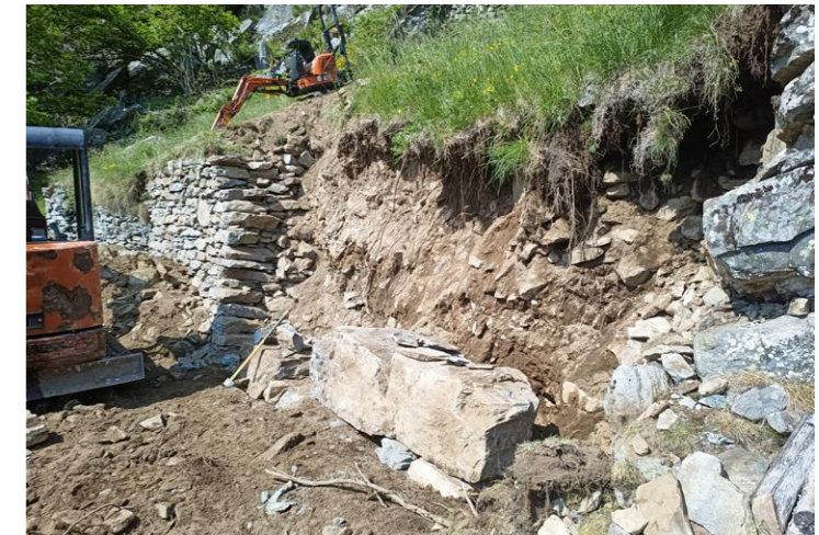
Während dem Wiederaufbau von Trockenmauern
