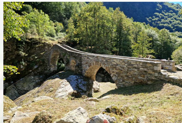
Die «Ponte della Merla» ist fertiggestellt
