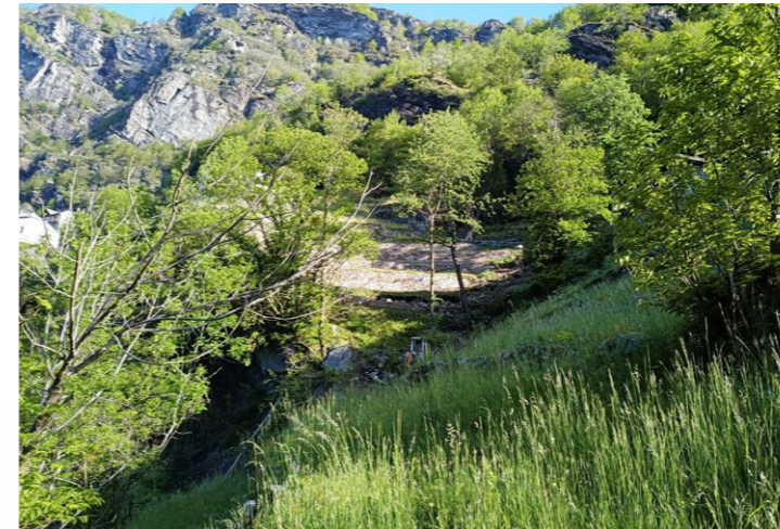
Blick auf die fertiggestellten Trockenmauern
