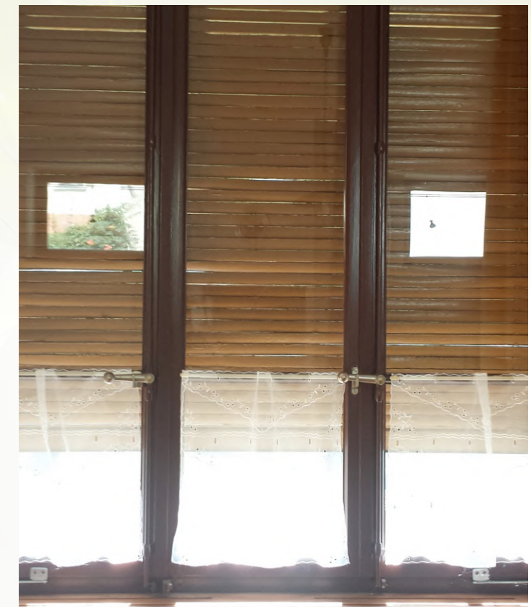
Fenêtres existantes dans la salle «Casa Patriziale»
