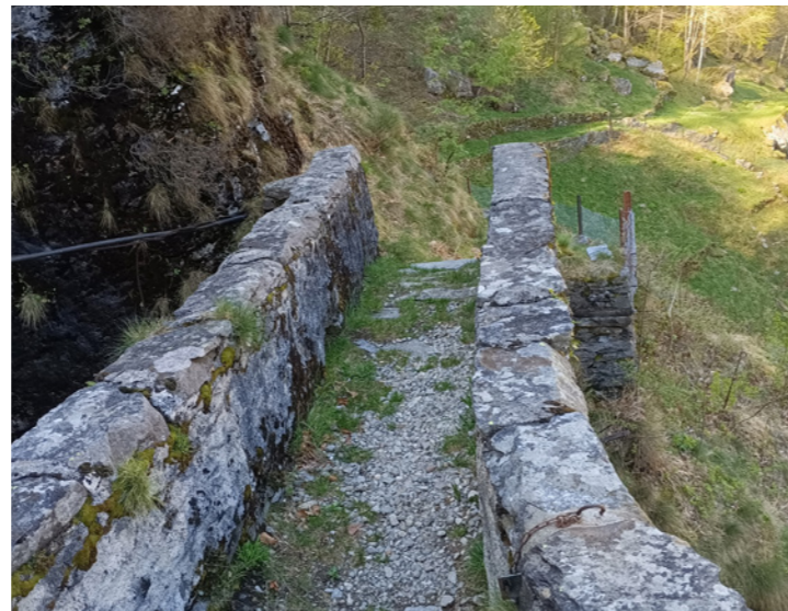
Eselsrückenbrücke «EL Puntign»
