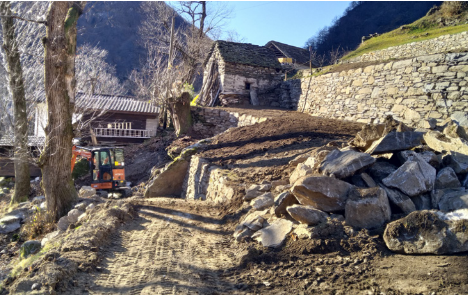
Terrassement à Cortaccio-Pianelli, les travaux avancent
