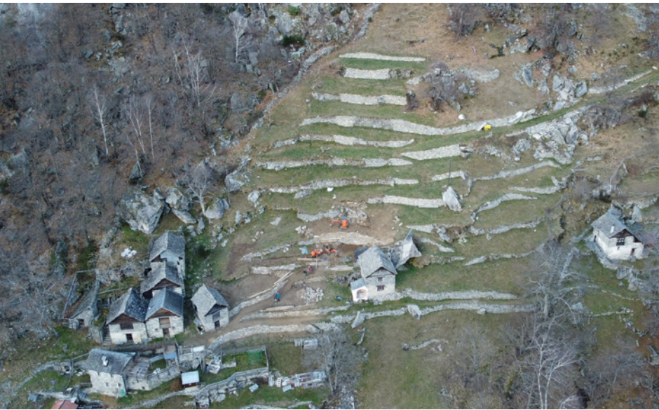
Vue arienne des terrassements à Margoneggia
