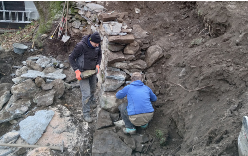
Beaucoup de travail manuel et expertise pour la reconstruction des murs en pierre sèches
