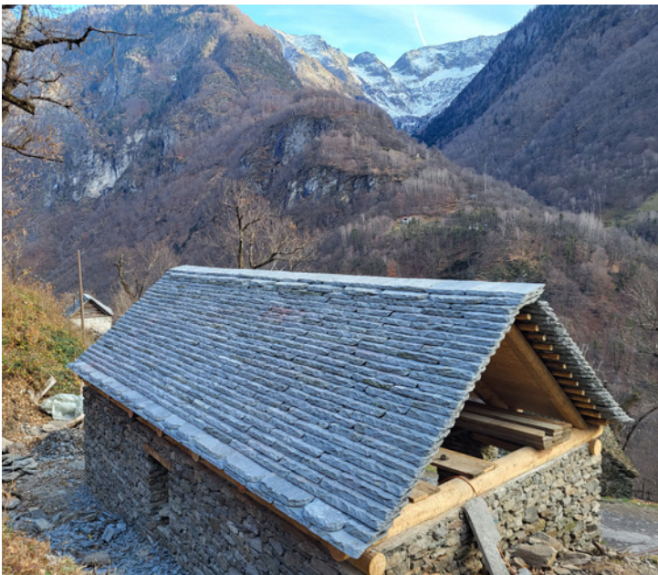
Nouvelle toiture en pierre du bâtiment 1 à Cortaccio-Pianelli
