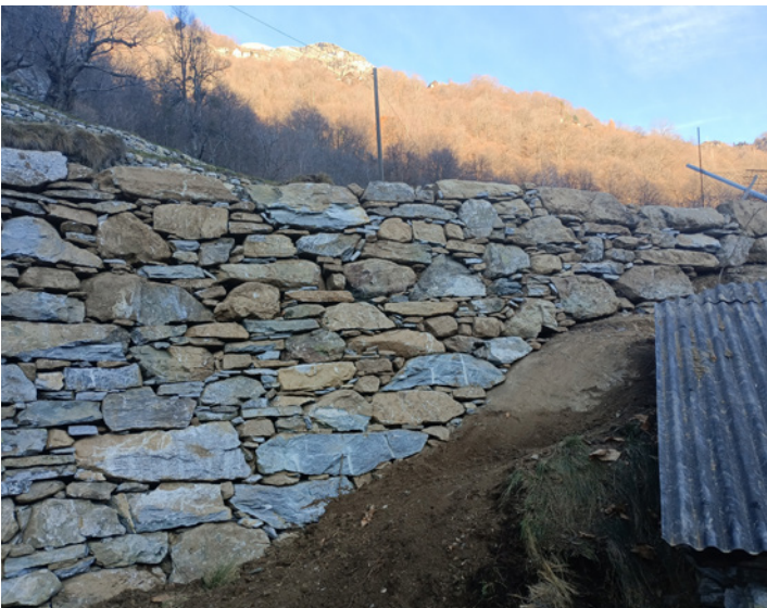
Détail du mur en pierre sèches reconstruit à Cortaccio-Pianelli
