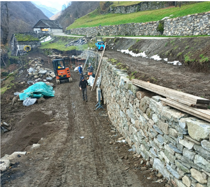
Cortaccio-Pianelli: travaux au murs en pierres sèches
