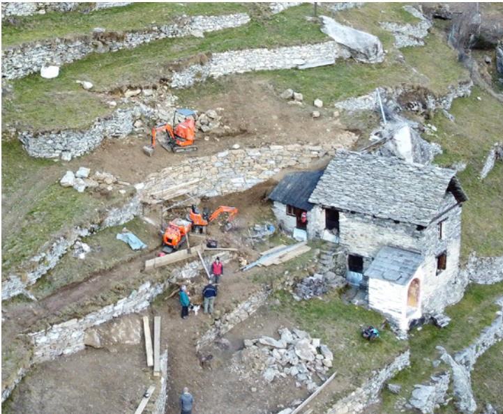
Margoneggia: travaux au murs en pierres sèches
