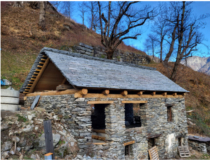
Renovation bâtiment 1 à Cortaccio-Pianelli
