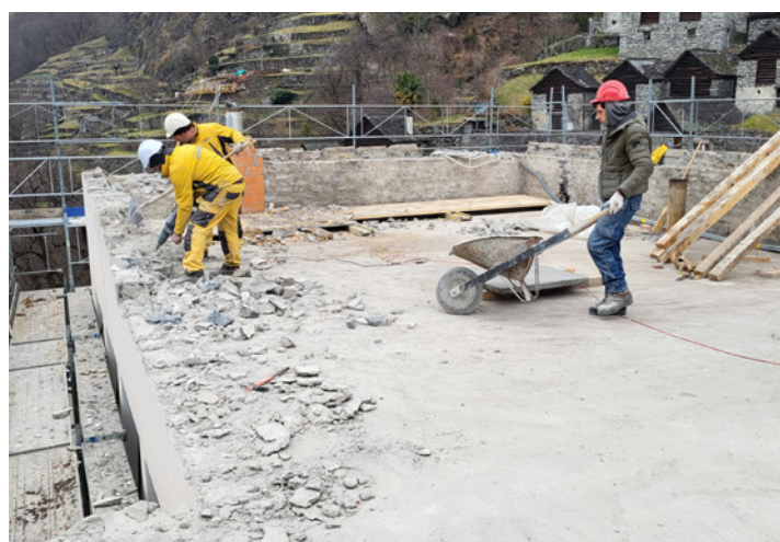
Sgombero dei detriti della Casa Patriziale
