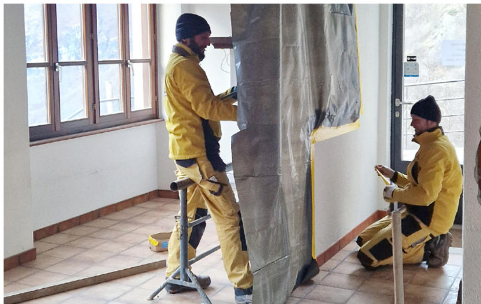
Operai al lavoro
