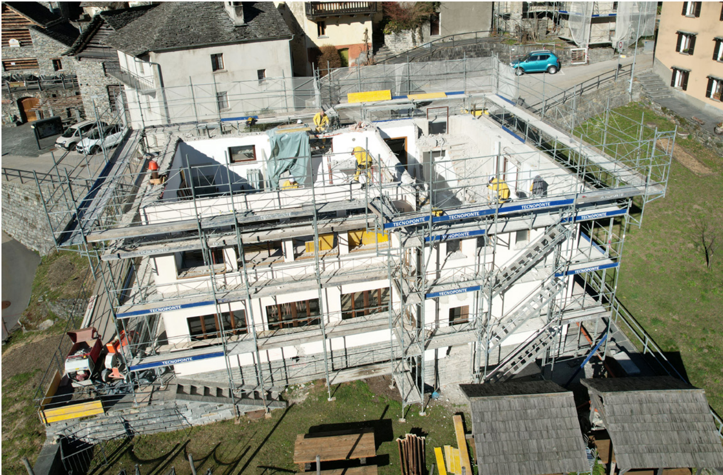
Casa Patriziale: veduta aerea dopo aver scoperchiato il tetto
