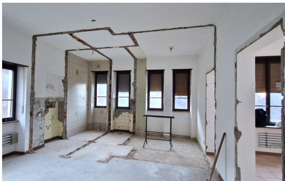
Risultato dopo la demolizione dei muri interni
