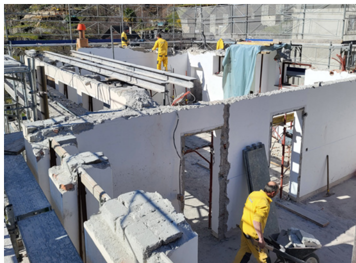
Il cantiere impegna diversi operai
