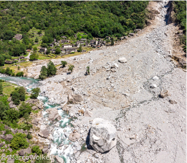
L'enorme frana che ha invaso gran parte del paesaggio di Fontana-Bosco-Mondada (Fonte: Dipartimento del Territorio)
