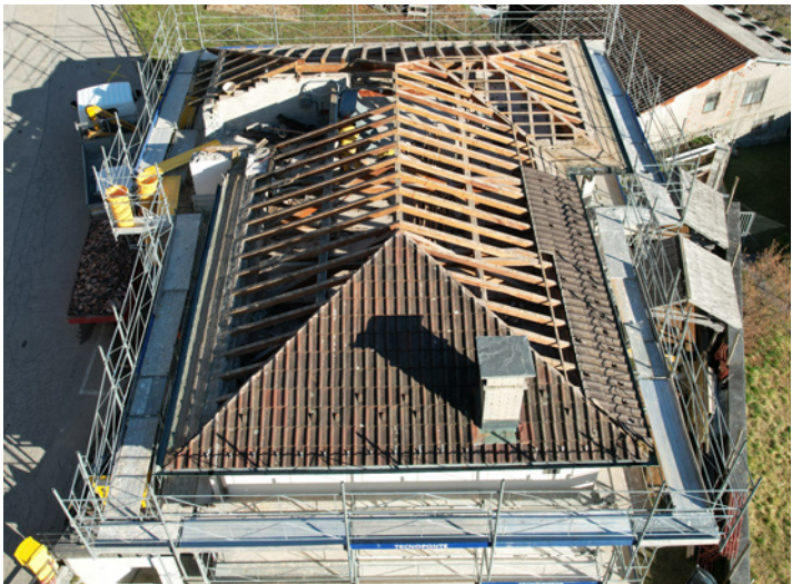
Progressi nello scoperchiamento del vecchio tetto
