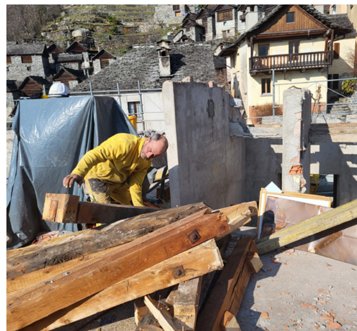
Carpenteria logorata del vecchio tetto
