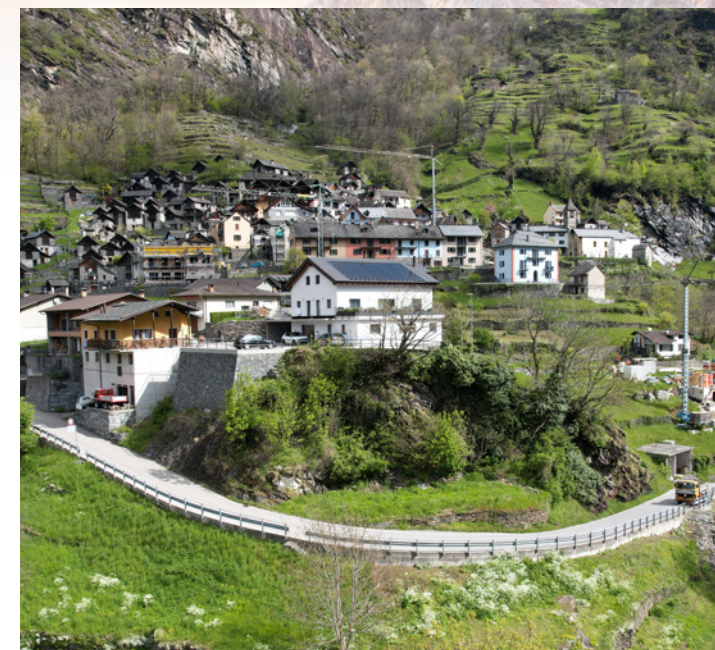
Blick auf den neuen Teil der Ortschaft Brontallo und das Projektgebiet
