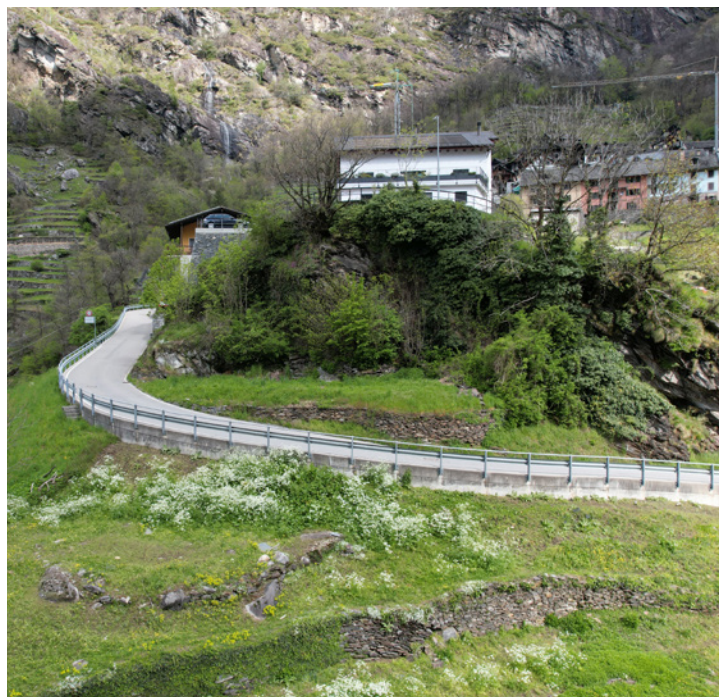
Terrasses nécessitant des travaux dans la zone de Mondacce
