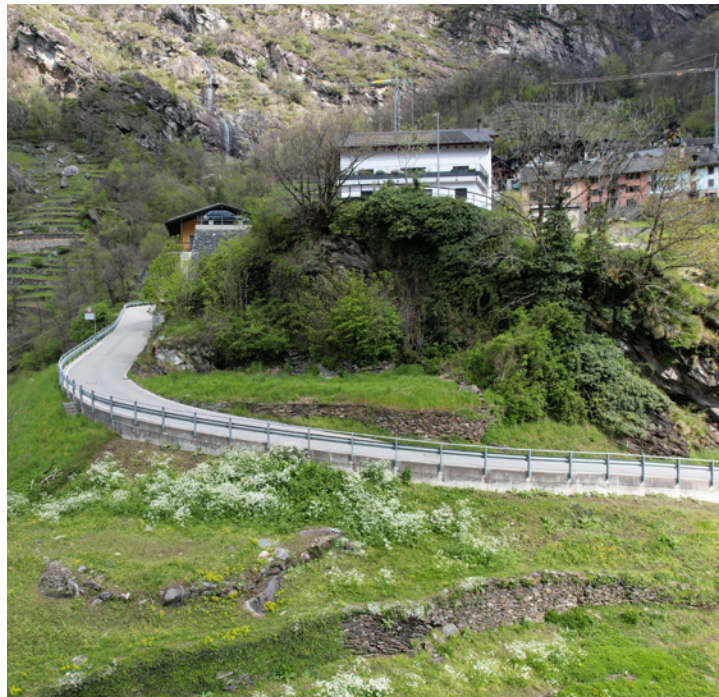
Terrazzamenti con necessità di intervento in zona Mondacce
