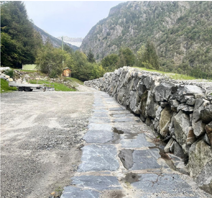
Innenseite eines Schutzwalls (Piano di Peccia – Lavizzara)
