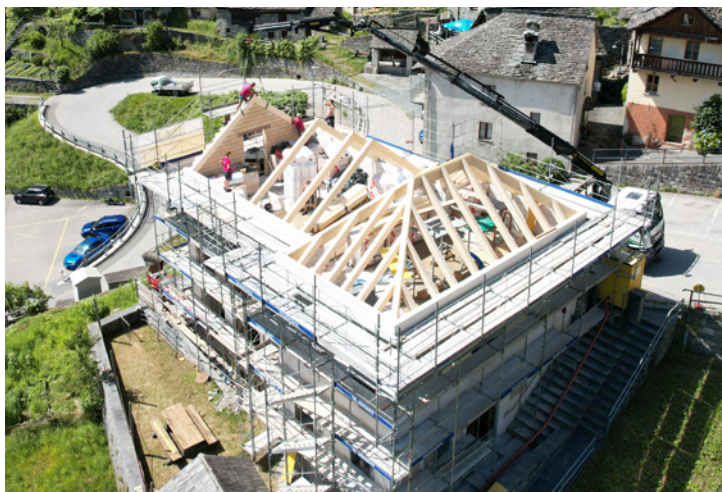
Bürgerhaus: Verlegung der Dachkonstruktion
