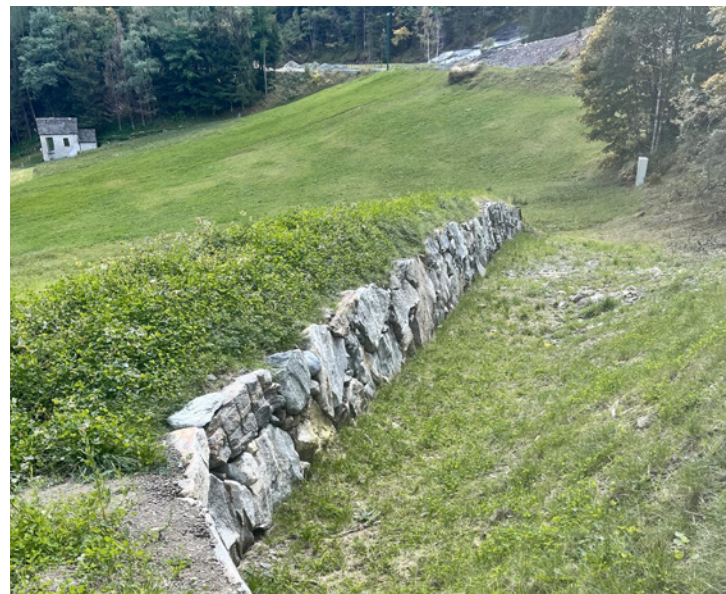
Schutzvorrichtung (Piano di Peccia – Lavizzara)
