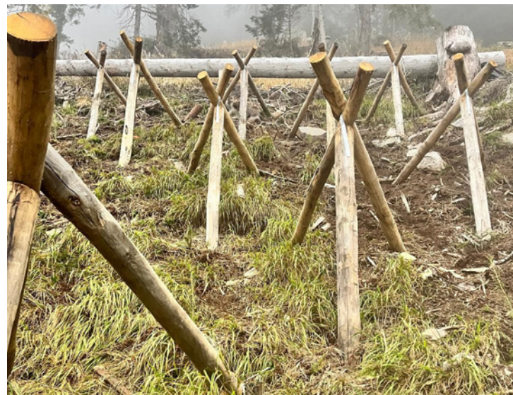
Dreibeinböcke: Massnahmen gegen Schneeschmelze (Piano di Peccia – Lavizzara)
