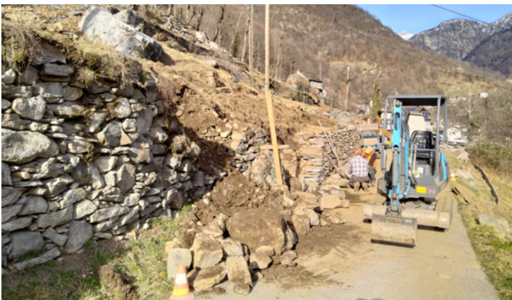
Cortaccio-Pianelli: wiederaufbau der Trockenmauern
