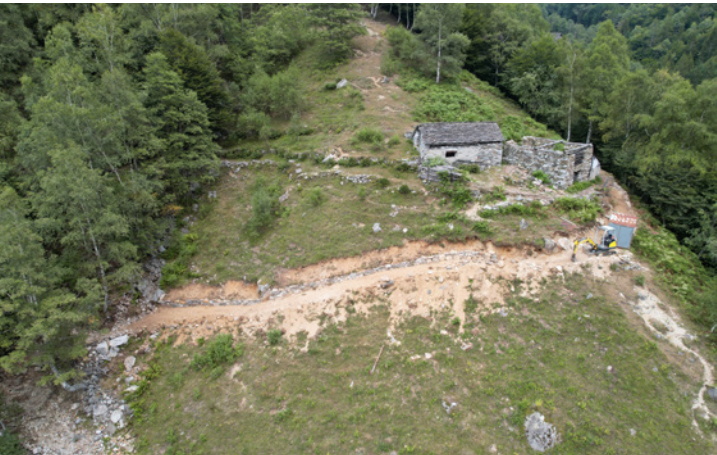
Val Serenello: travaux aux sentiers
