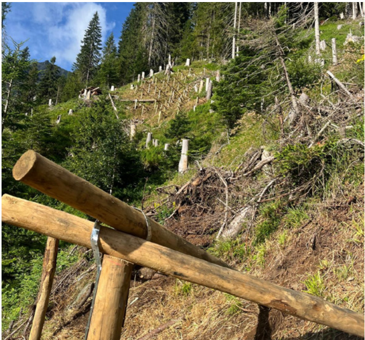
Vue sur la pente sécurisée avec des trépieds (Piano di Peccia – Lavizzara)
