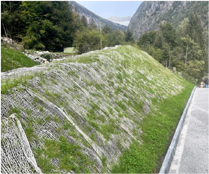
Rempart protégeant une zone habitée (Piano di Peccia – Lavizzara)
