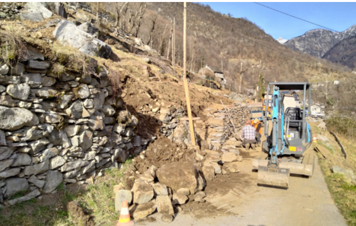
Cortaccio-Pianelli: reconstruction des murs en pierres
