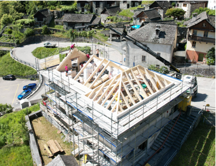
Casa patriziale: couverture en bois pour la toiture en pierre plates
