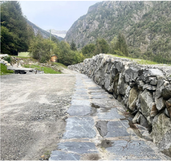
Partie interne d'un rempart de protection (Piano di Peccia – Lavizzara)
