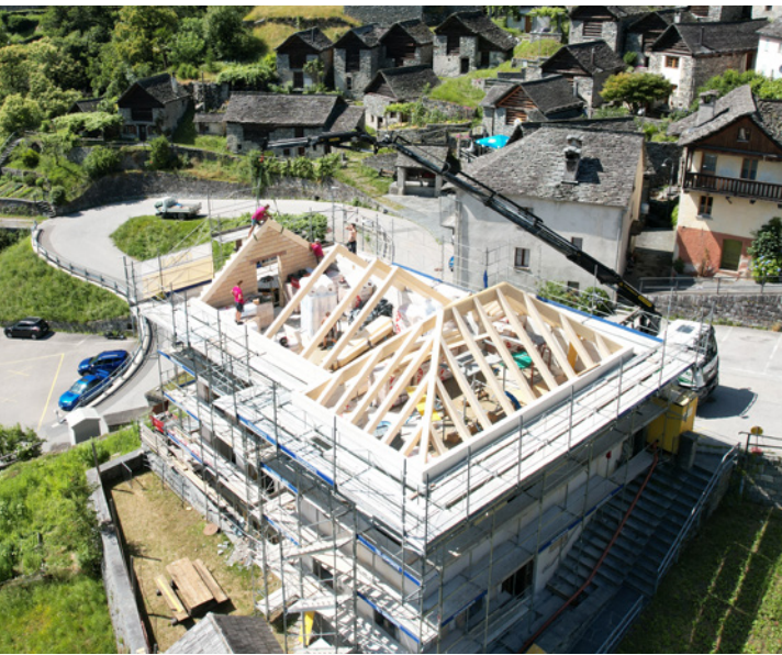
Casa Patriziale: posa della carpenteria del tetto in piode
