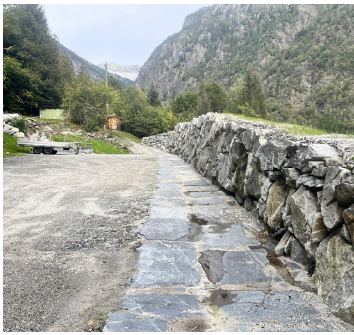
Parte interna di un vallo di protezione (Piano di Peccia – Lavizzara)
