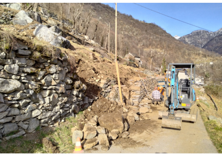
Cortaccio-Pianelli: ricostruzione muri a secco
