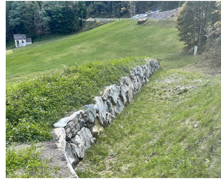
Vallo di protezione (Piano di Peccia – Lavizzara)
