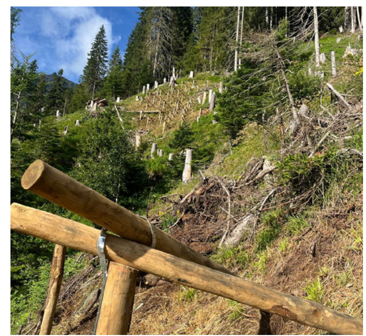
Vista pendio premunito con cavalletti treppiedi (Piano di Peccia – Lavizzara)
