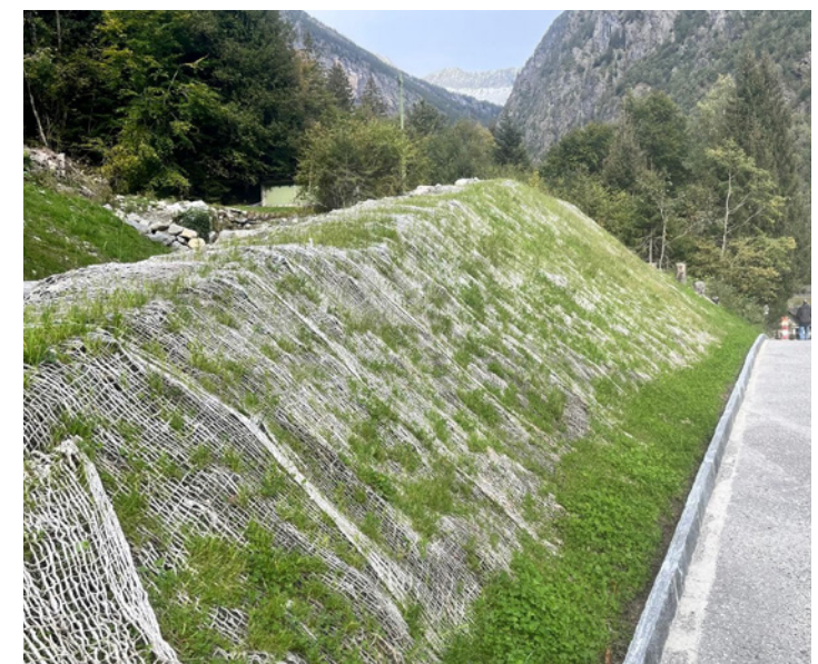
Vallo a protezione di una zona abitata (Piano di Peccia – Lavizzara)
