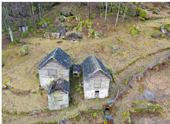
Die Gebäude in Gerbi
