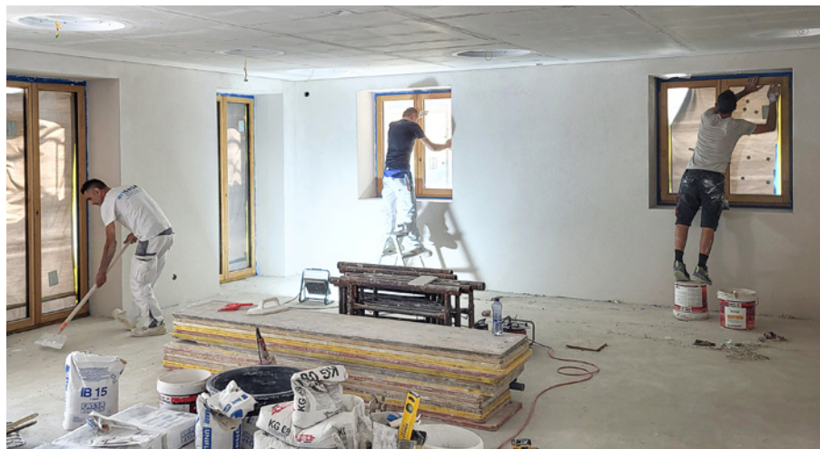
Gipser bei der Arbeit
