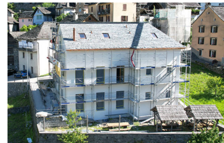
Das Casa Patriziale während der Sanierung
