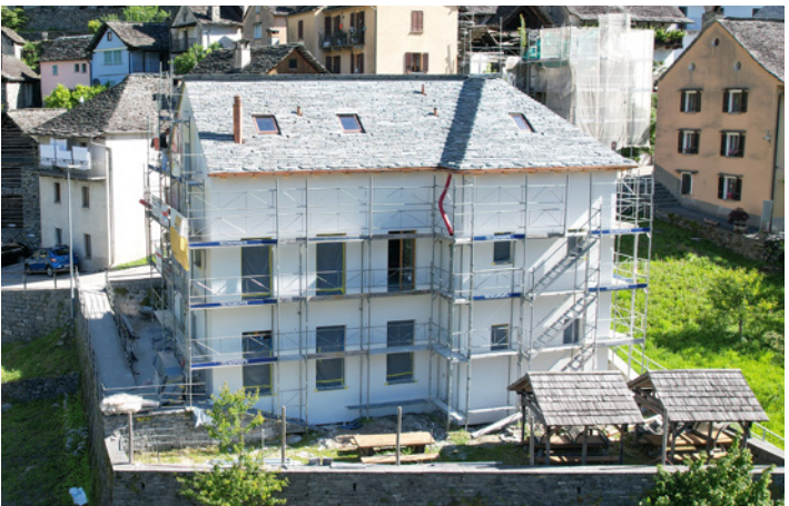
La maison bourgeoise pendant les travaux de rénovation
