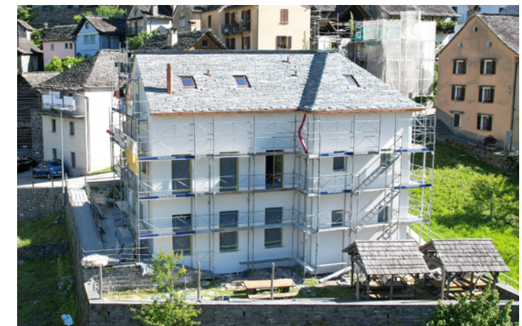
La Casa patriziale durante i lavori di ristrutturazione
