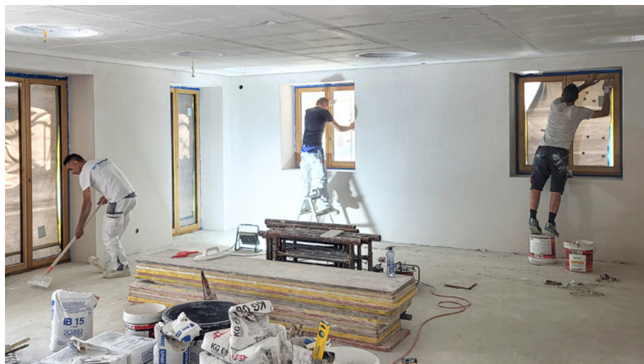
Gessatori al lavoro
