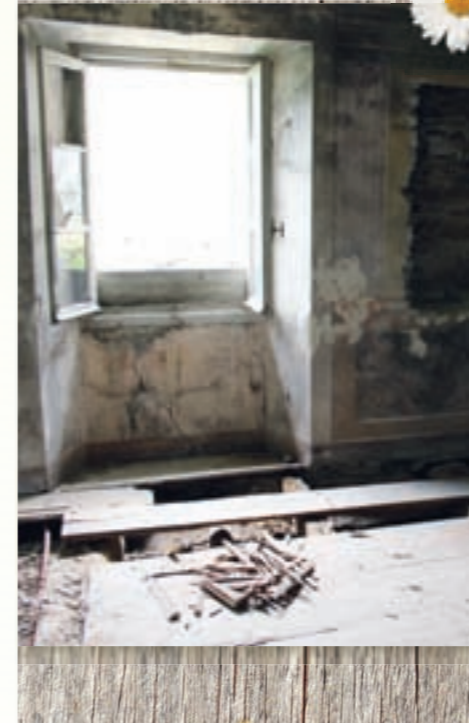
Während den Abrissarbeiten
