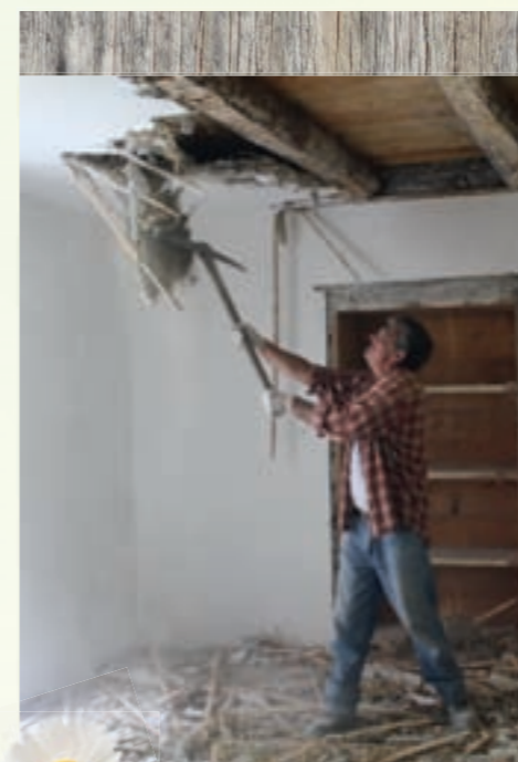
Travaux de démolition
