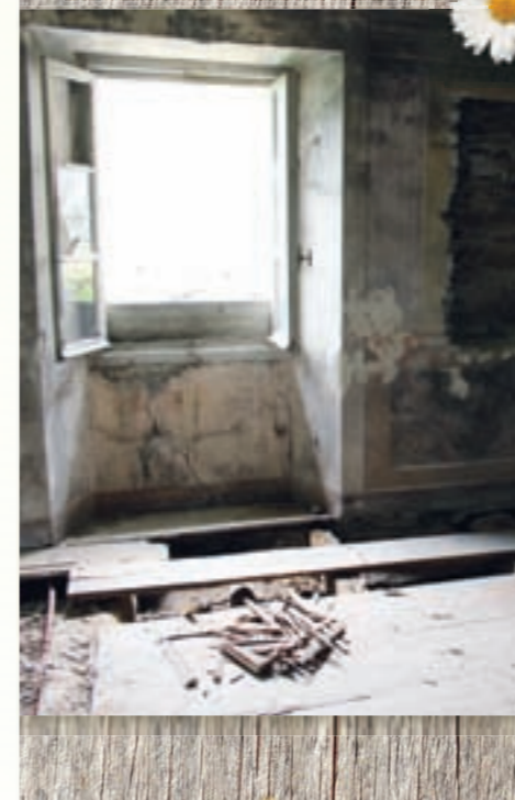
Situation pendant la démolition
