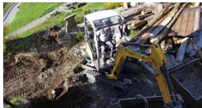
Arbeiten an "Casa Fiori"
