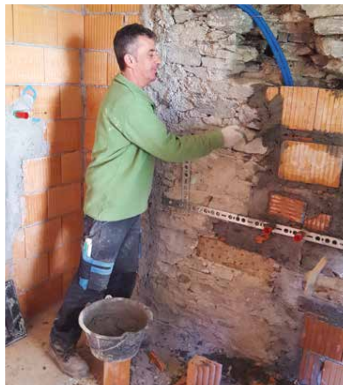
Arbeiter bei der Arbeit in "Casa Fiori"
