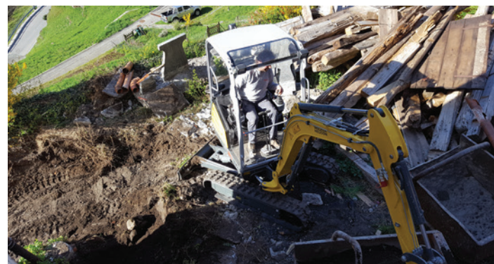
Travaux à "Casa Fiori"
