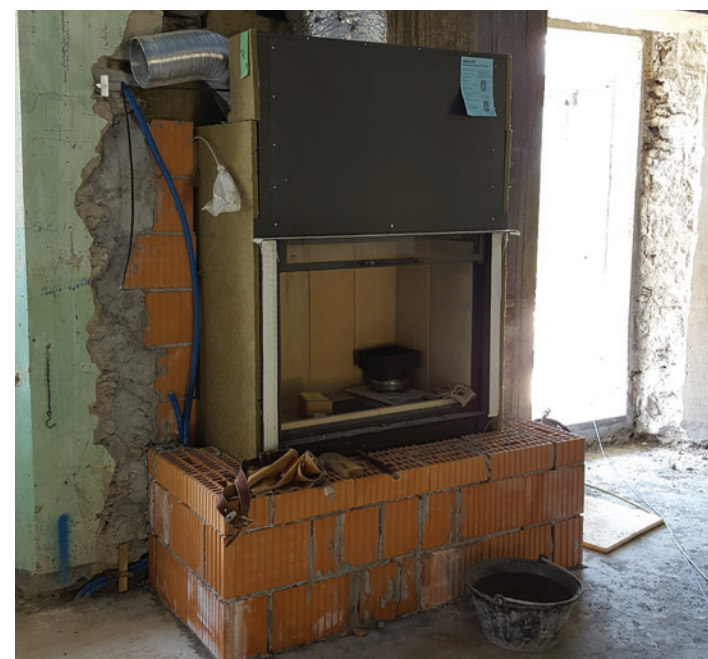
Détail de l'intérieur de "Casa Fiori".
