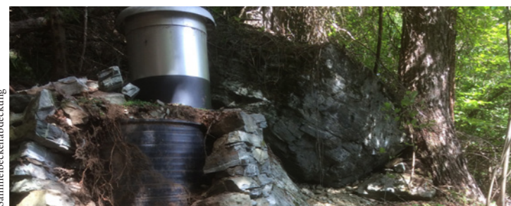
Instandsetzung der Sammelbeckendeckung
