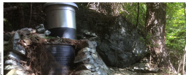
Reconstruction du mur de protection pour le bassin.
