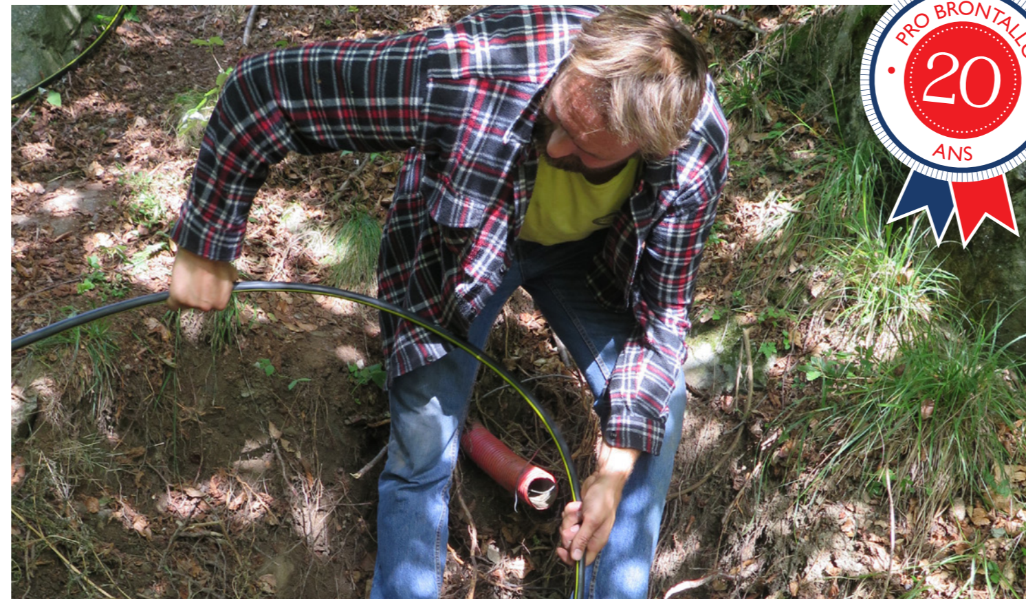
Pose du câble
