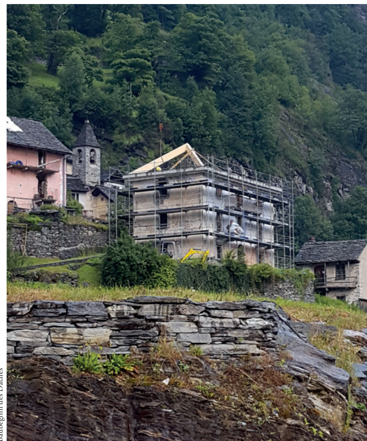
Baubeginn des Daches
