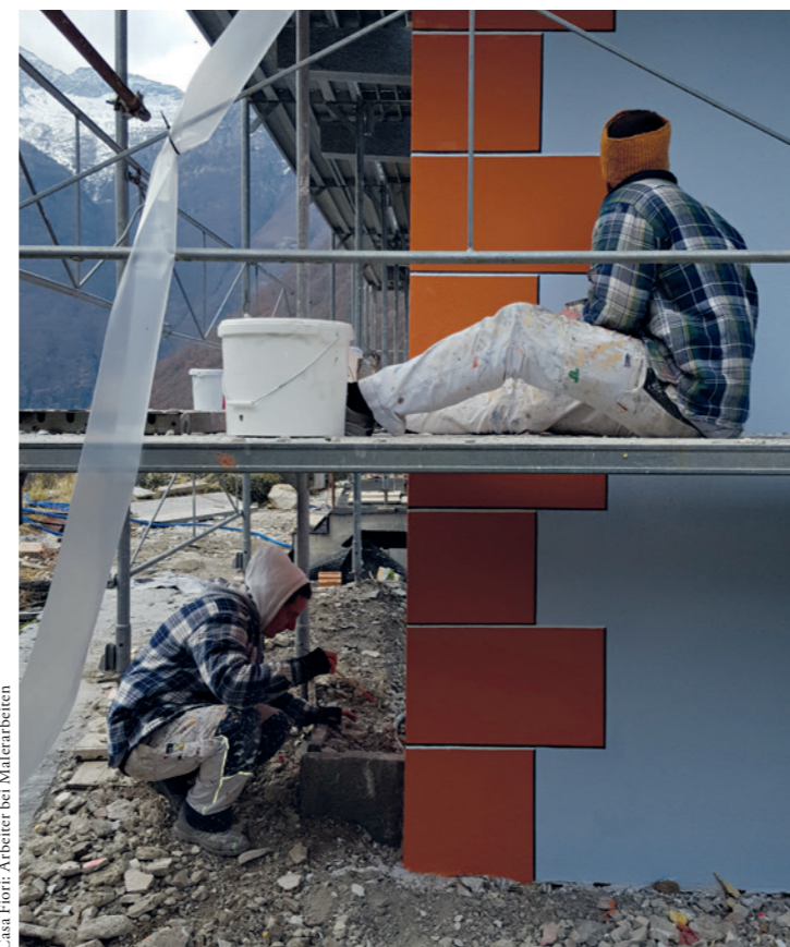
Casa Fiori: Arbeiter bei Malerarbeiten
