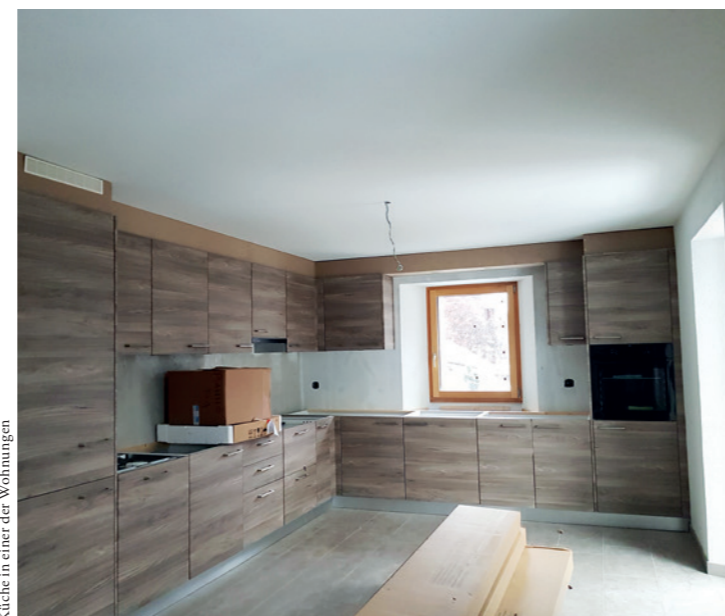
Küche in einer der Wohnungen
