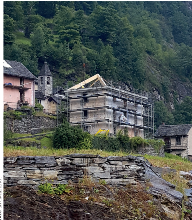
Début des travaux au toit
