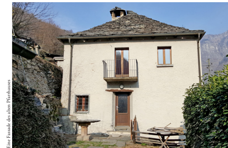
Eine Fassade des alten Pfarrhauses
