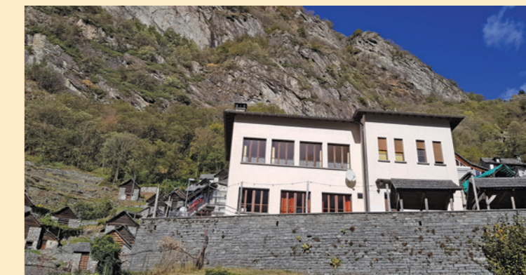
Die Isolation von Fenster und Türen haben Priorität.
