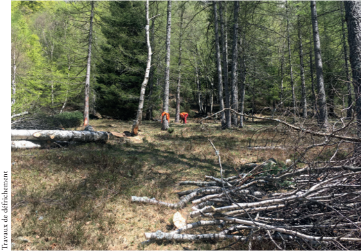
Travaux de défrichage
