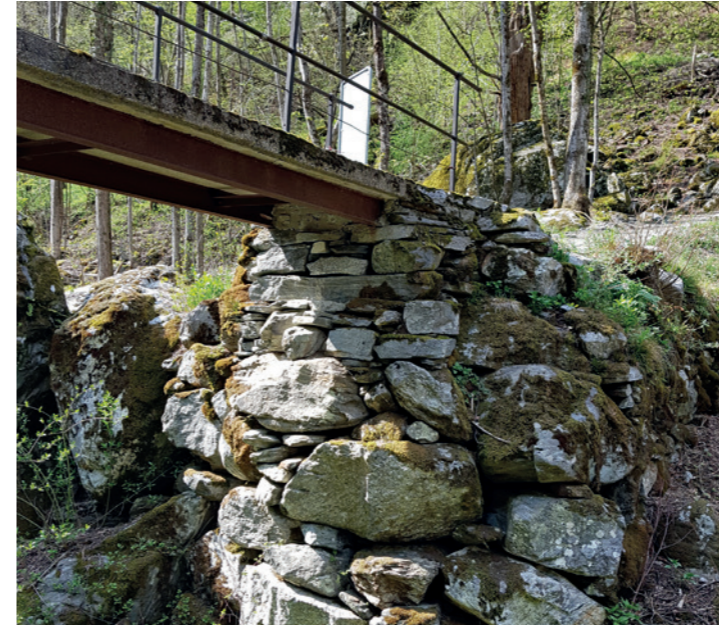
Partie du pont en béton armé
