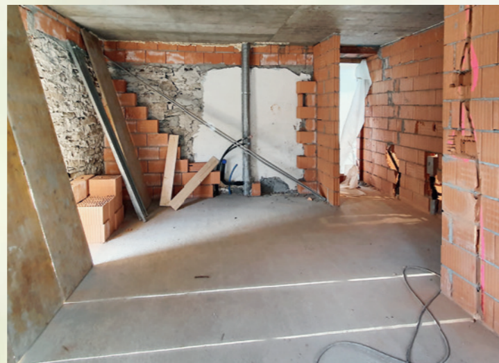
Travaux de reconstruction
