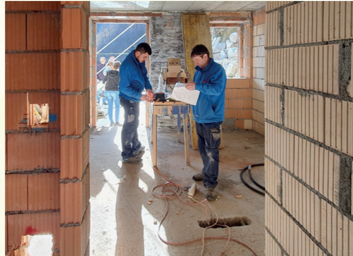
Ouvriers aux travaux
