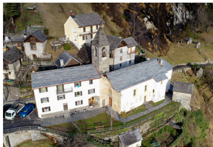
Le toit de l'église est terminé
