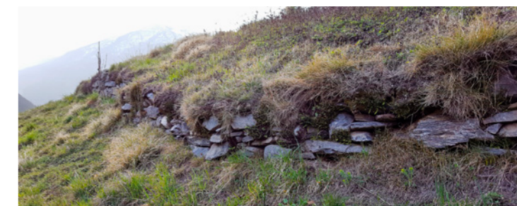
Murs de pierres sèches en localité Coste
