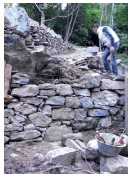
Wiederinstandstellung der Trockenmauern am Saumpfad Brontallo-Menzonio
