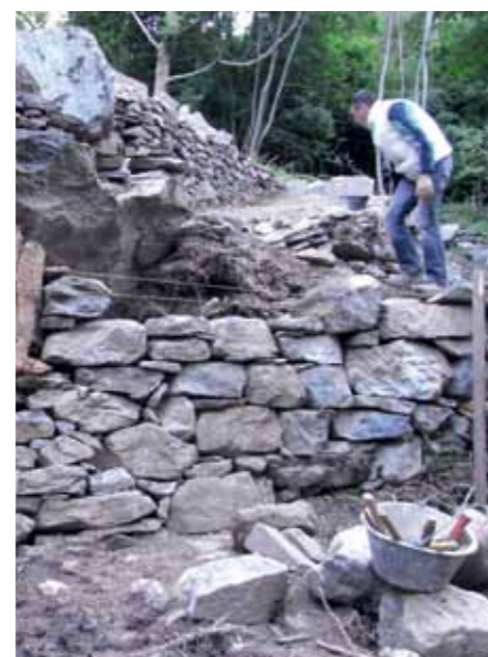
Rénovation des murs des pierres sèches chez l'ancienne sentier muletier entre Brontallo et Menzonio
